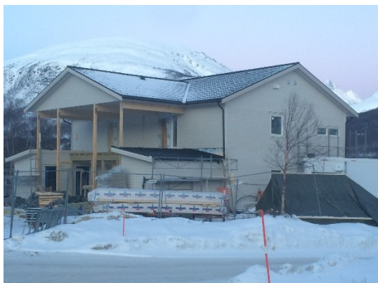
Kommunale boliger under oppføring på Oteren.
