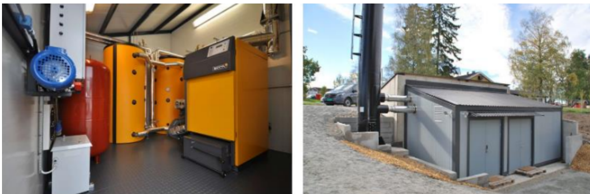
Figur 8 Eksempel på modulbasert varmeanlegg. (kilde: ETA Norge AS)
