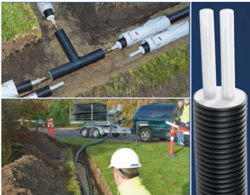
Figur 9 Eksempel distribusjon/kobling av fleksibelt pex rør (twin type). Dette røret kan leveres opp til 63mm, med varmeeffekt opp mot 250 kW. Produktet som figuren viser har toleranse på hhv 85-90°C og 10 bars trykk. Leveres i lengder mellom 50 eller 100 m (Kilde: Logstore).
