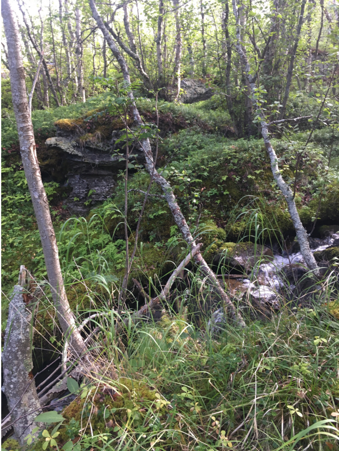
Figur 14 Klipper utspring i fjellsiden
