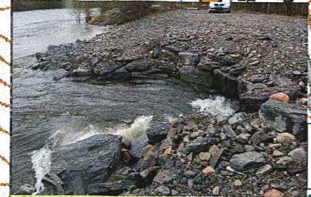
Innløp halvkulvert Flom i Reisaelva
