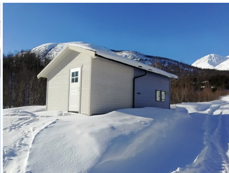
Utvidet bygning for UV-anleggene på Elvevoll og i Tverrdalen.
